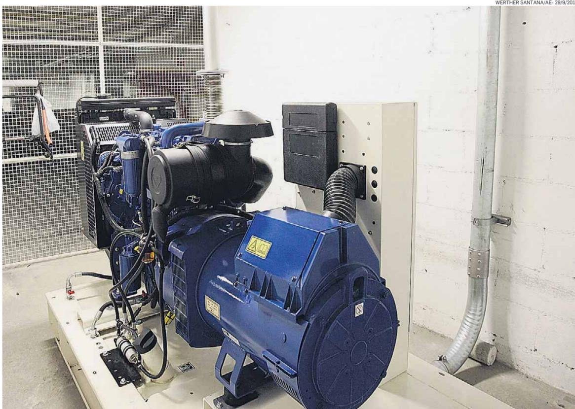
**Instalação.** Por conta da emissão de ruídos, gerador deve ficar em local isolado. Na falta do espaço, existe a opção silenciada
